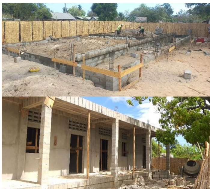
Etat du chantier en janvier 2026
