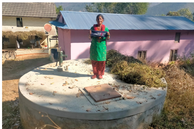
Réservoir d'eau (Népal)
