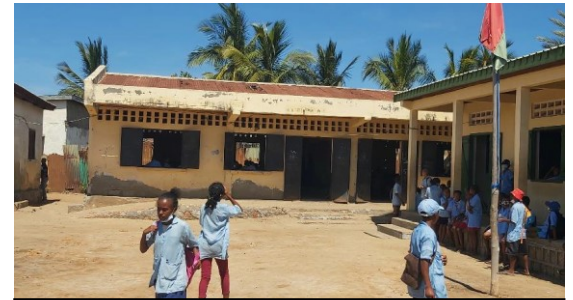
Bâtiment de 2 salles de classe construit en 2019
