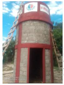
La construction d'un petit château d'eau destiné à fournir de l'eau aux lavabos des toilettes a été réalisée ainsi que l'installation d'une borne fontaine. D'une capacité de 3 000 litres, construit en "ferro-ciment" dans la cour de l'école primaire publique mixte du quartier "Namahora" à Morondava il alimente environ 200 élèves et leurs 7 enseignants en eau.
