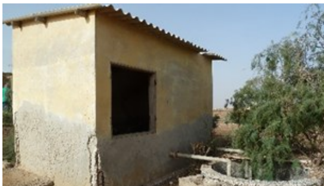
Ancienne station de pompage
