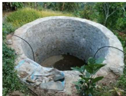
récupérateur d'eau de pluie en construction
