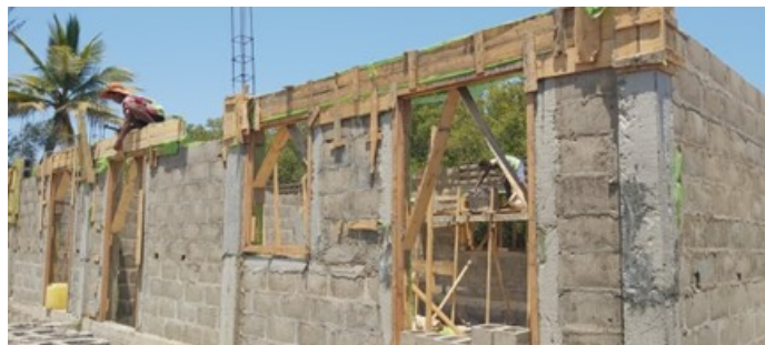
Travaux en cours
